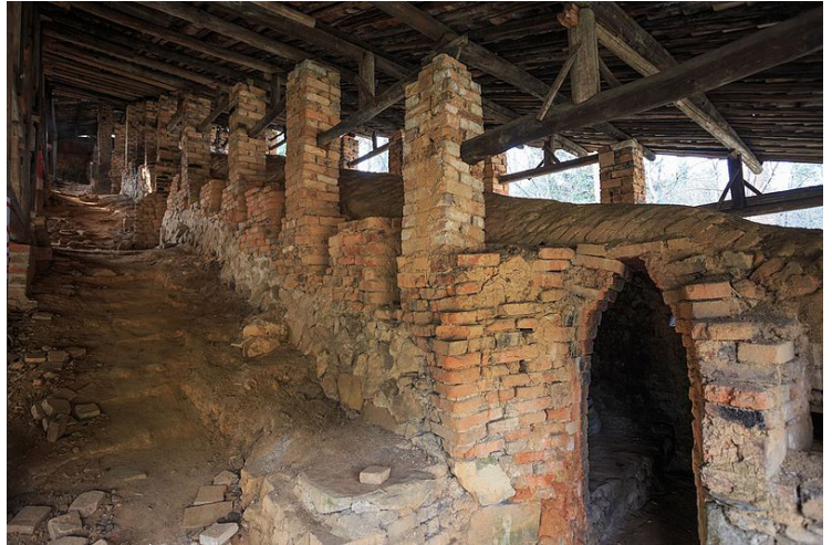
Figura 1.9 – Forno inclinado (forno dragão) da província de Sanqingkou, China 15
