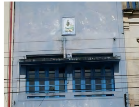
Figura 34: Fachada antes da reforma
