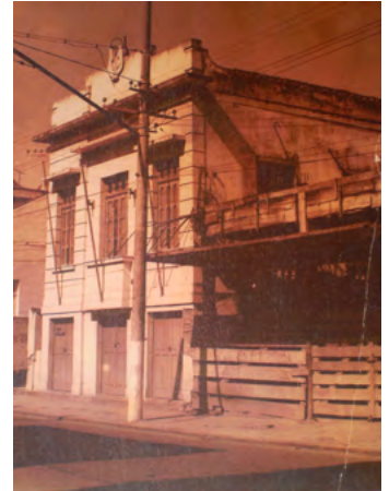
Figura 42: Prédio erguido em 1967
