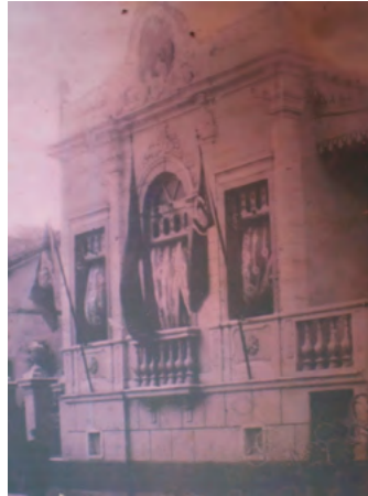
Figura 41: Primeiro prédio reformado, em 1964
