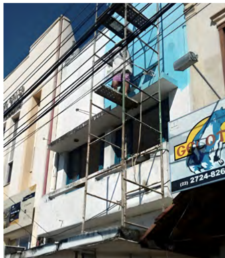
Figura 35: Durante a reforma
