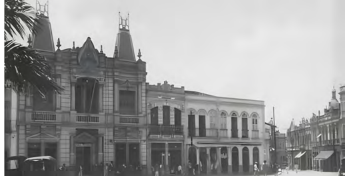
Figura 14: Foto antiga da sede antes do incêndio ocorrido em 1990
