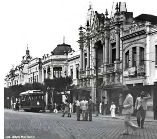
Figura 15: Foto antiga da sede antes do incêndio ocorrido em 1990
