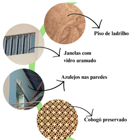
Figura 5 - Representação dos materiais usados modernistas da antiga Rodoviária de Cajazeiras-PB
