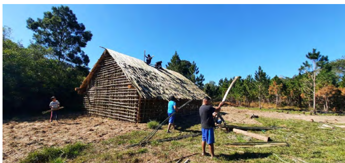
Figura 3 - Construção da casa de reza (opy) na aldeia Pará Rokê.
